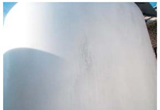
Eingetrocknete Säurereste auf der Bauteiloberfläche durch ungenügendes Spülen
