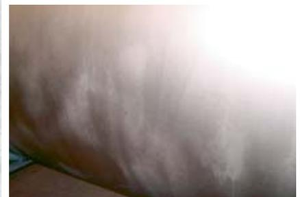
Fleckenbildung an der Bauteiloberfläche durch falsches Aufsprühen des Beizgels
